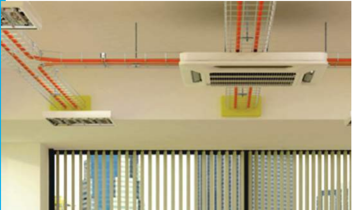
Algar Class '0' Basket Matting Connection Example / Kablo Koruyucu Bağlantı Örneği
